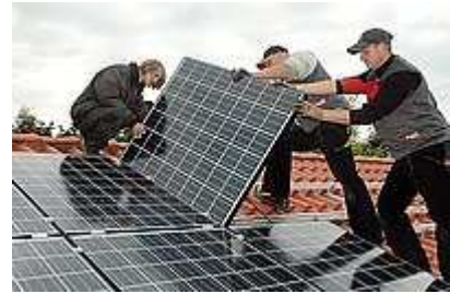
Feinarbeit: Andreas Süper, Boris Berch und Thomas Wagener (v. l.) befestigen ein Modul auf dem Bauhof in Horn. Foto: Brinkmeier
